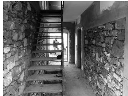
Nella casa di Rompeggio rifatto pavimento, intonaco, impianto elettrico, tetto del salone e ampliato il portico.
