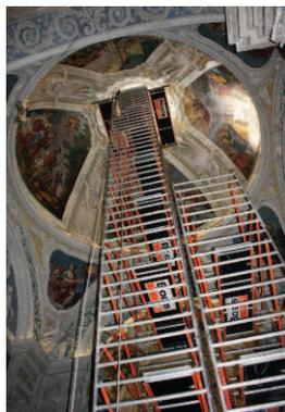
A sinistra l'ardito ponteggio verticale per sistemare i serramenti e cambiare i vetri del cupolino; a destra, studio e prove per la scelta delle tessere vitree.
